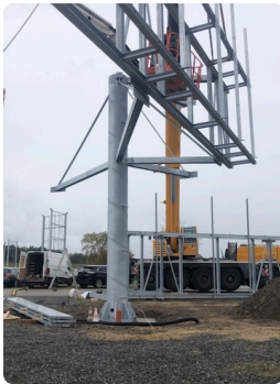
1 Stahlbau Pylon und Tragrahmen aus eigenem Metallbau, feuerverzinkt
