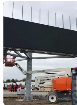
4 Bestücken Die LED-Kabinette werden eingesetzt und verkabelt
