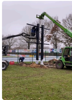
3 Am Platz Der Mast steht, das Fundament trägt, die Kabel liegen
