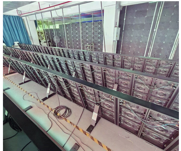
Vormontage der LED-Bande.
