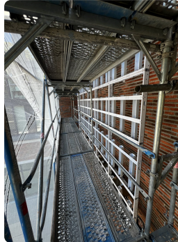
2 Befestigung Schienen an der Wand, hier vor einer Klinkerfassade
