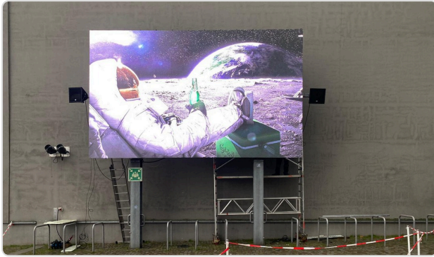
LED-Wand vor einer Giebelwand bei der Inbetriebnahme, keine direkte Fassadenmontage.
