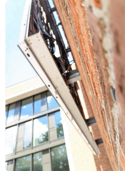
4 Tragwerk Doppel-T-Träger an der Fassade, von unten gesehen
