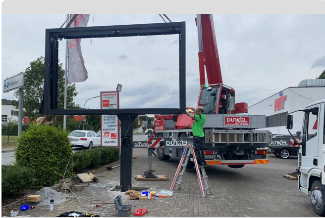
Kranmontage am Gewerbestandort. Pylon und Tragrahmen werden aufgestellt.
